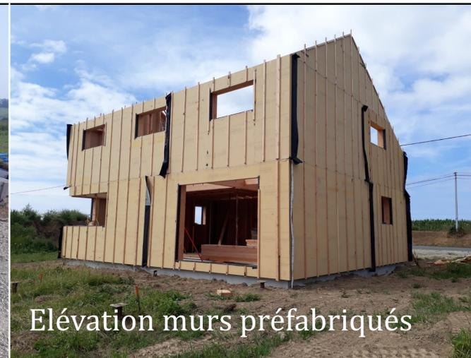
Élévation murs préfabriqués
